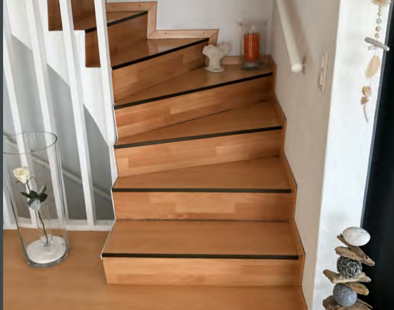
Treppe vor Renovation
